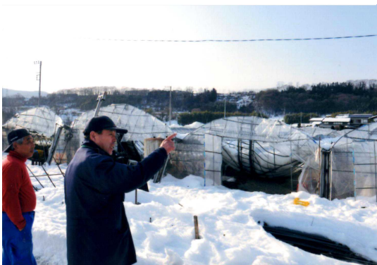
●2月19日(水)ハウスの倒壊状況を視察・激励する「星野已喜雄」
